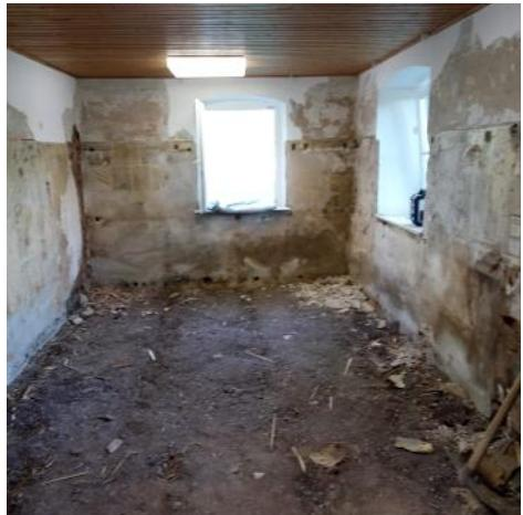
So beschlossen wir, alles zu entnehmen und den Raum grundhaft zu sanieren. Nach Einbringen der Abdichtung zum Keller hin, wurde der Bodenaufbau komplett neu errichtet. Ebenso wurde feuchtig-
